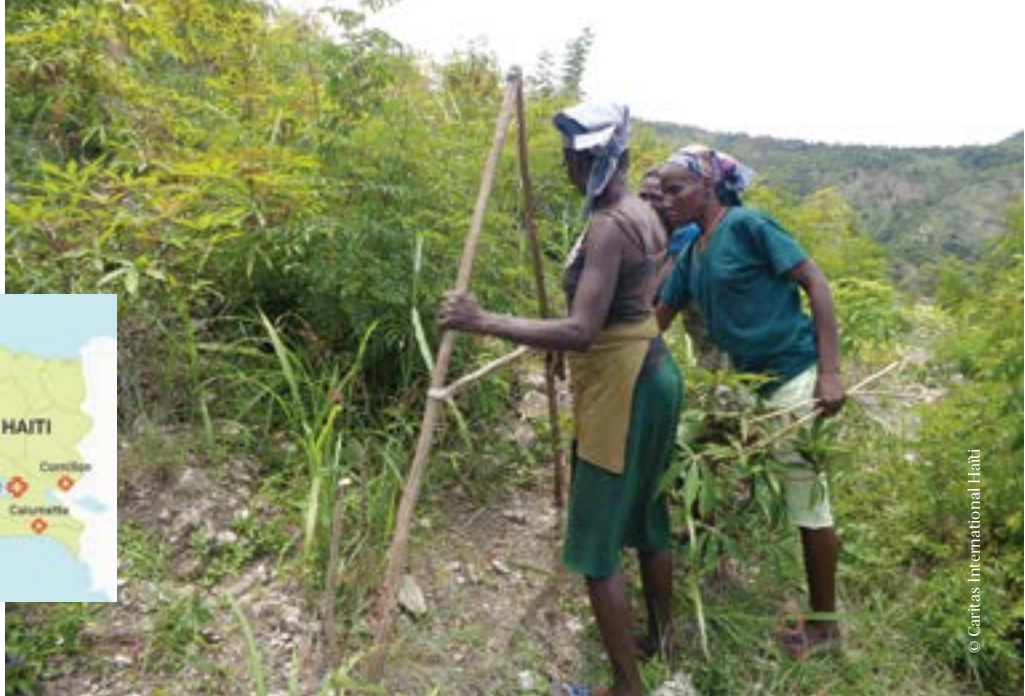
▲ Caritas International werkt met lokale partners en boerengroeperingen aan duurzame landbouw in het zuiden van Haïti. Deze vrouwen leggen terrassen aan om erosie tegen te gaan.
